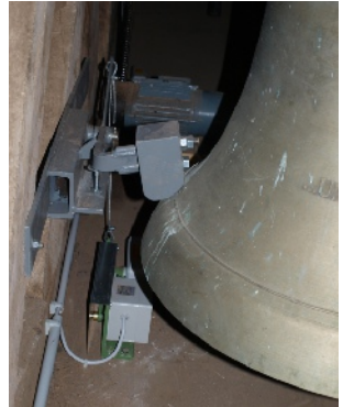
Der Hammer für den Stundenschlag
